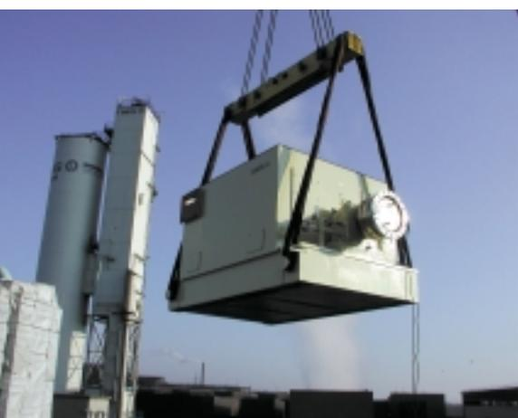
Anlieferung des Antriebmotors für die Luftzerlegungsanlage in Dillingen
